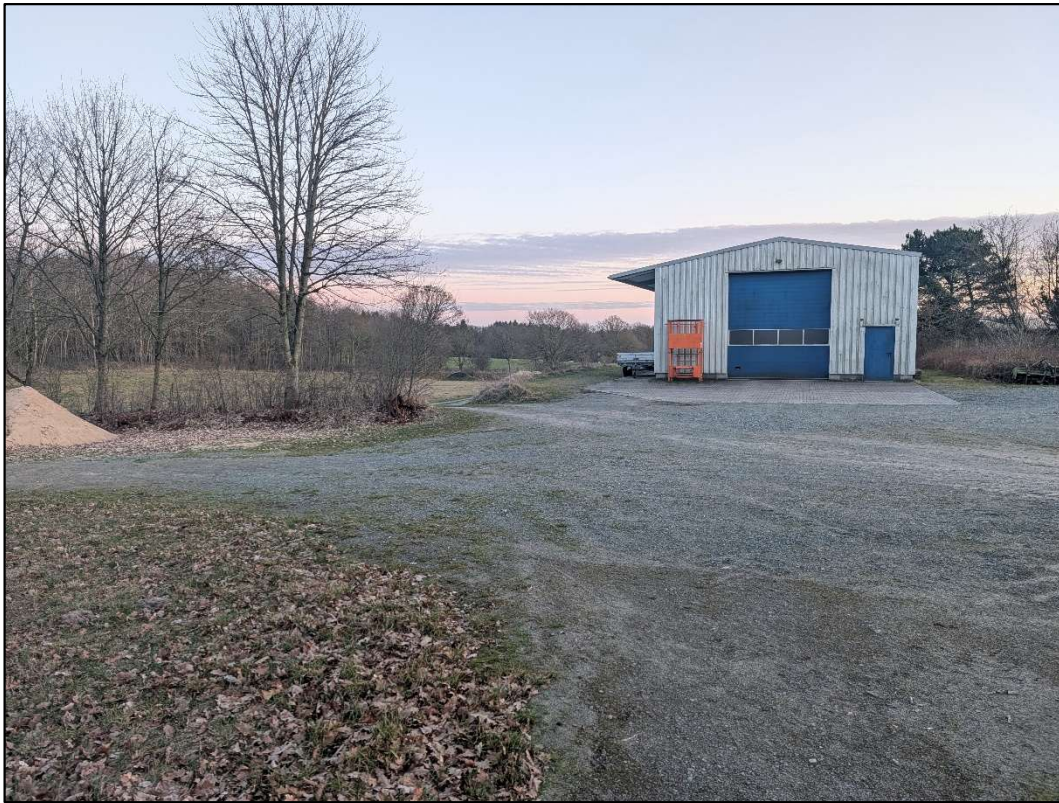
Abbildung 2: Halle auf dem Grundstück des Wasserwerkes, in deren Anschluss die BESS-Container errichtet werden sollen
