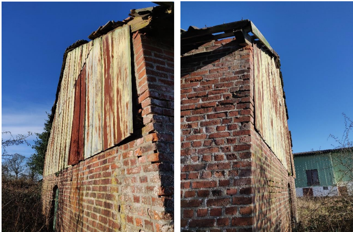
Abb. 3a: Südseite des Stallgebäudes mit überhängender Blechfassade, die als potentielles Fledermausquartier angesehen werden kann.
