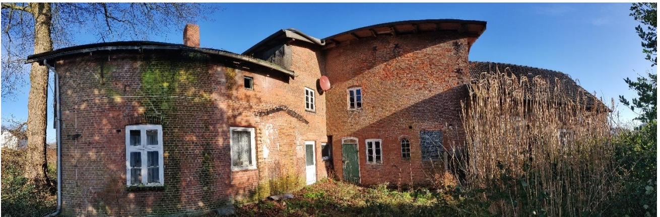
Abb. 3d: Südansicht des Gebäudes. Im Bereich des Dachüberstandes und im Mauerwerk sind eine Vielzahl potentieller Fledermausquartiere und Tagesverstecke vorhanden.
